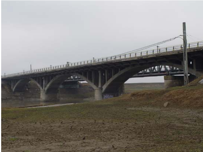
Fig. 1.1. Bridge on NR 28A, km 22+660 .
